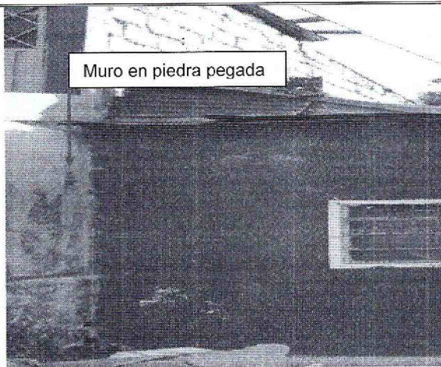
Foto No. 2. Muro en piedra pegada, costado nor-occidental. Vivienda de la Calle 1A Bis No. 5 -43 Este.
