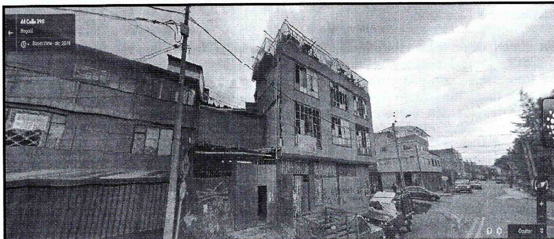
Fotografía 1. Vista general de la fachada y del predio ubicado en la Calle 39 Sur No 69-22, en el Sector Provivienda, de la Localidad de Kennedy, antes de que se produjera la conflagración. Tomado de Google Maps.
