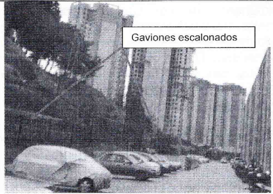
Foto No. 2. Vista de las obras de contención en el talud de corte en el predio de la Diagonal 68 D Sur No. 70 C - 31.
