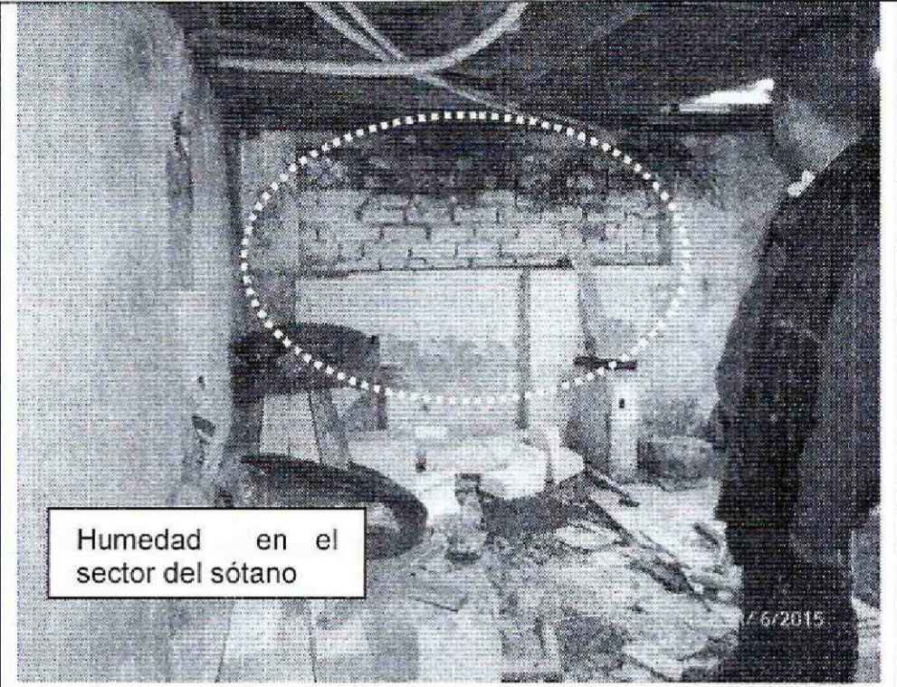
Fotografía 4. Humedad presentada en los muros del sótano de la parte posterior del local comercial ubicado en el predio de la Carrera 24 No. 45B-45, en el sector catastral Palermo de la localidad de Teusaquillo.
