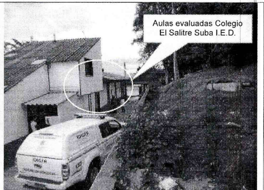
Fotografía 2. Vista de la fachada de la edificación del costado Sur, Colegio El Salitre Suba I.E.D. Sede A.
