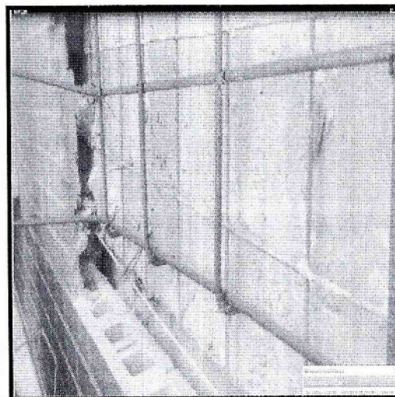
Fotografía 6. Detalle del refuerzo diseñado para el recalce de las placas en los sectores de los ductos cubiertos por la mampostería.
