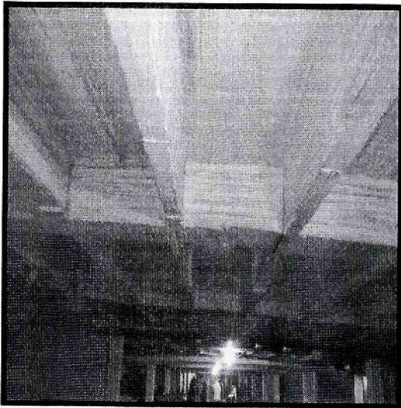
Fotografía 16 y 17. Fisuras de tendencia longitudinal en la parte inferior de la torta superior de la placa de primer piso.
