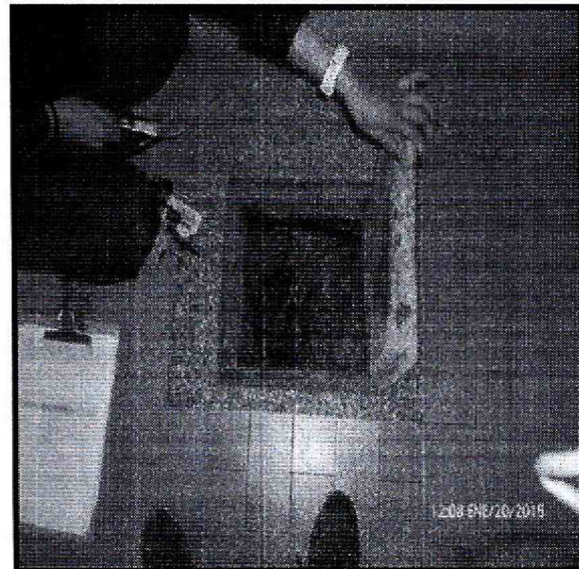
Fotografías 8 y 9. Presencia de agua en las cajas de Polo Tierra en los pasillos de las Torres 2, 6 y 7
