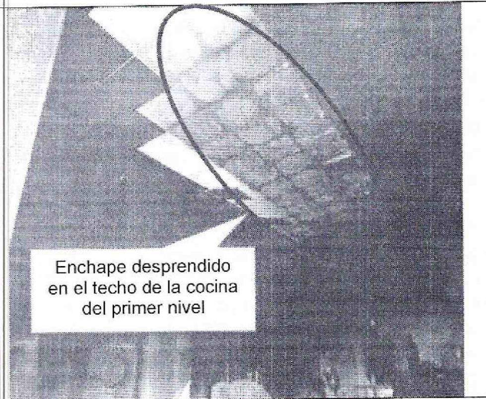
Fotografía 3. Enchape desprendido en el techo de la cocina del primer nivel, contigua a la habitación donde se produjo la conflagración.
