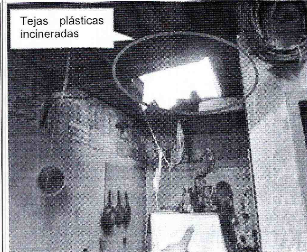
Fotografía 5. Tejas plásticas incineradas en la cubierta de la cocina del cuarto nivel de la edificación
