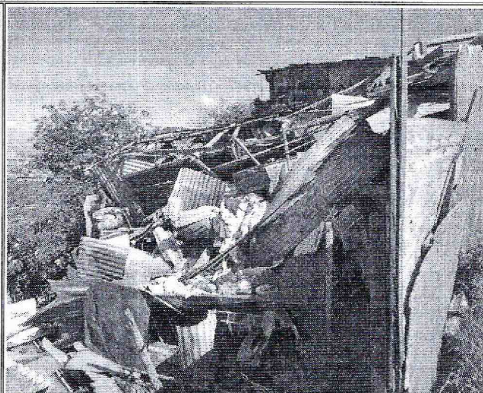
Foto No. 2. Vista posterior del predio de la Calle 62 B No. 18 Q – 56 Sur, Barrio Altos de Jalisco en la Localidad de Ciudad Bolívar
