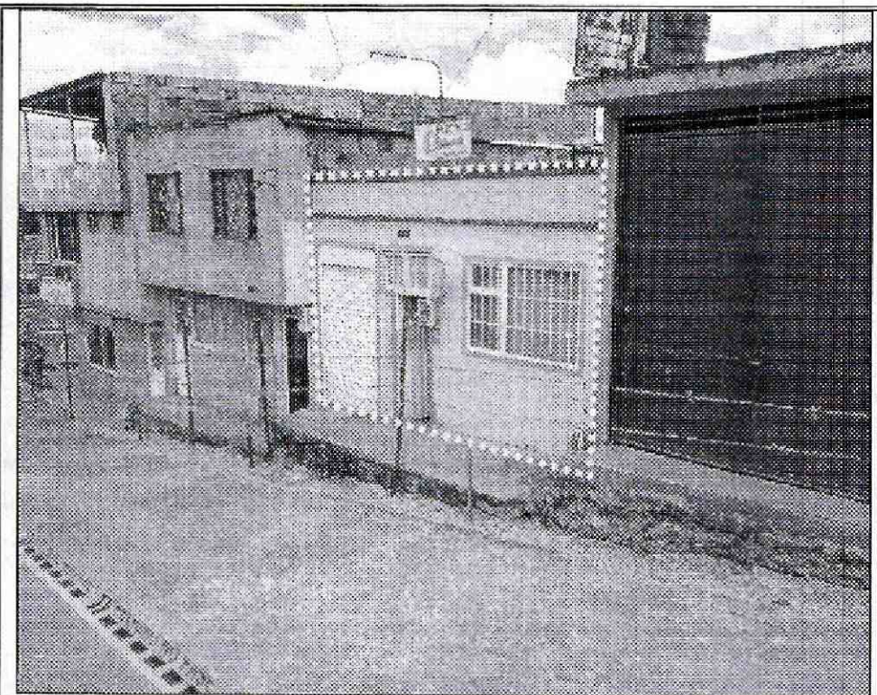
Fotografía 2. Vista de la fachada de la vivienda evaluada y ubicada en el predio de la Calle 50F Sur No. 5B-70, en el barrio el Portal II sector de la localidad Rafael Uribe Uribe, se observa que corresponde a una vivienda de un (1) nivel construida en una ladera de pendiente moderada.
