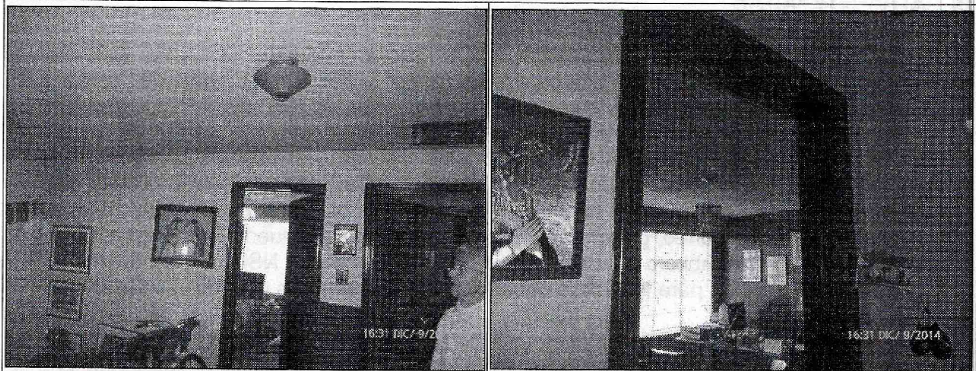
Fotografía 5 y 6. Vista del interior de la vivienda emplazada en el predio de la Calle 62 No. 24-63, Sector Catastral El Campin de la Localidad de Teusaquillo, en la cual no se identifican fisuras, grietas u otro tipo de afectación que indique compromiso en la estabilidad estructural y habitabilidad de la vivienda en el corto plazo bajo cargas normales de servicio.
