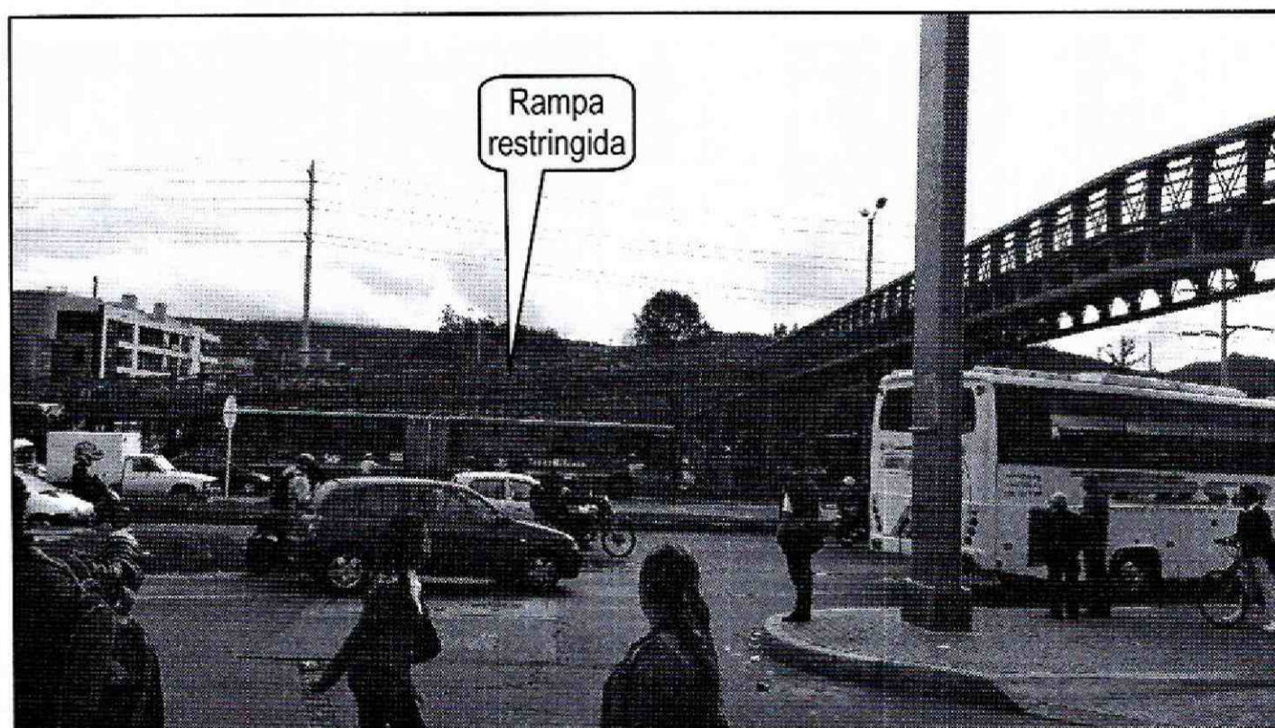
Fotografía 10. Vista del sector restringido por las afectaciones en el pedestal de la rampa de acceso a la estación "Alcalá" de la Autopista Norte con Calle 134
