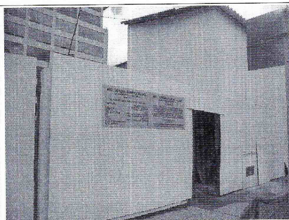
Foto 4. Detalle del predio donde se adelantan labores de obra.
