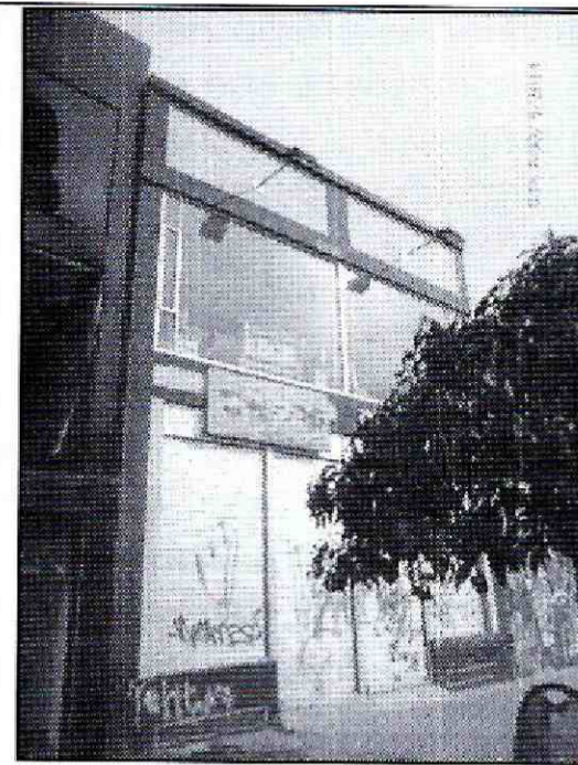
Fotografía 4. Vista de la fachada de la edificación emplazada en el predio de la Carrera 10 No. 1B-53, Sector Catastral San Bernardino de la Localidad de Santa Fe, en el cual con base en la inspección visual desde el exterior, no se identificó ningún tipo de afectación relacionada con la conflagración.
