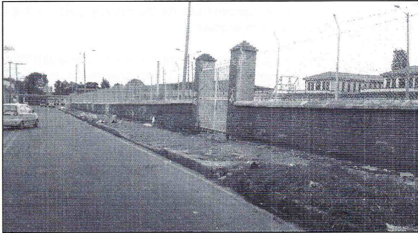
Fotografía 1. Vista del Muro de cerramiento costado sur del Parque del Sector Catastral Sevilla ubicado en la Calle 2 Sur No.13A-16 del Sector Catastral La Hortúa de la Localidad de Antonio Nariño
