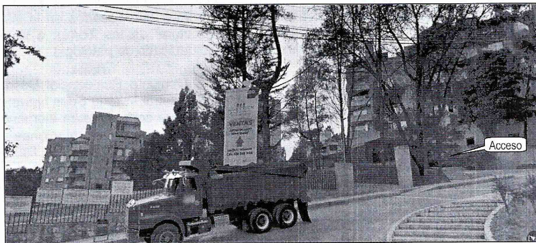
Fotografía 1. Fachada del Conjunto Residencial Bosque Verde ubicado en la Calle 131 No. 78A-61 del Sector Catastral Vereda Suba Naranjos de la Localidad de Suba
