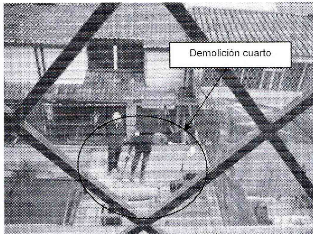
Foto 24. Proceso de demolición de un cuarto ubicado en la parte posterior evidenciada en el predio con nomenclatura "2. Carrera 9B # 117A-73" del Sector Catastral Santa Bárbara Central de la Localidad de Usaquén.
