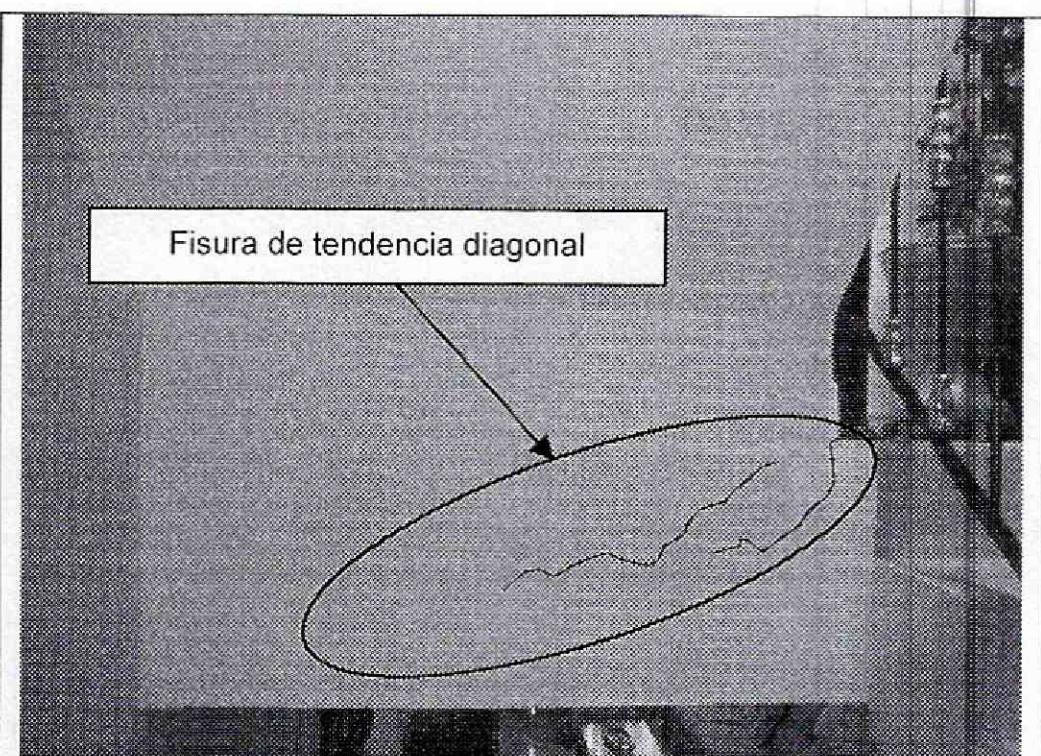
Foto 6. Fisura de tendencia diagonal evidenciada en el predio con nomenclatura "1. Carrera 9B # 117A-71" del Sector Catastral Santa Bárbara Central de la Localidad de Usaquén.
