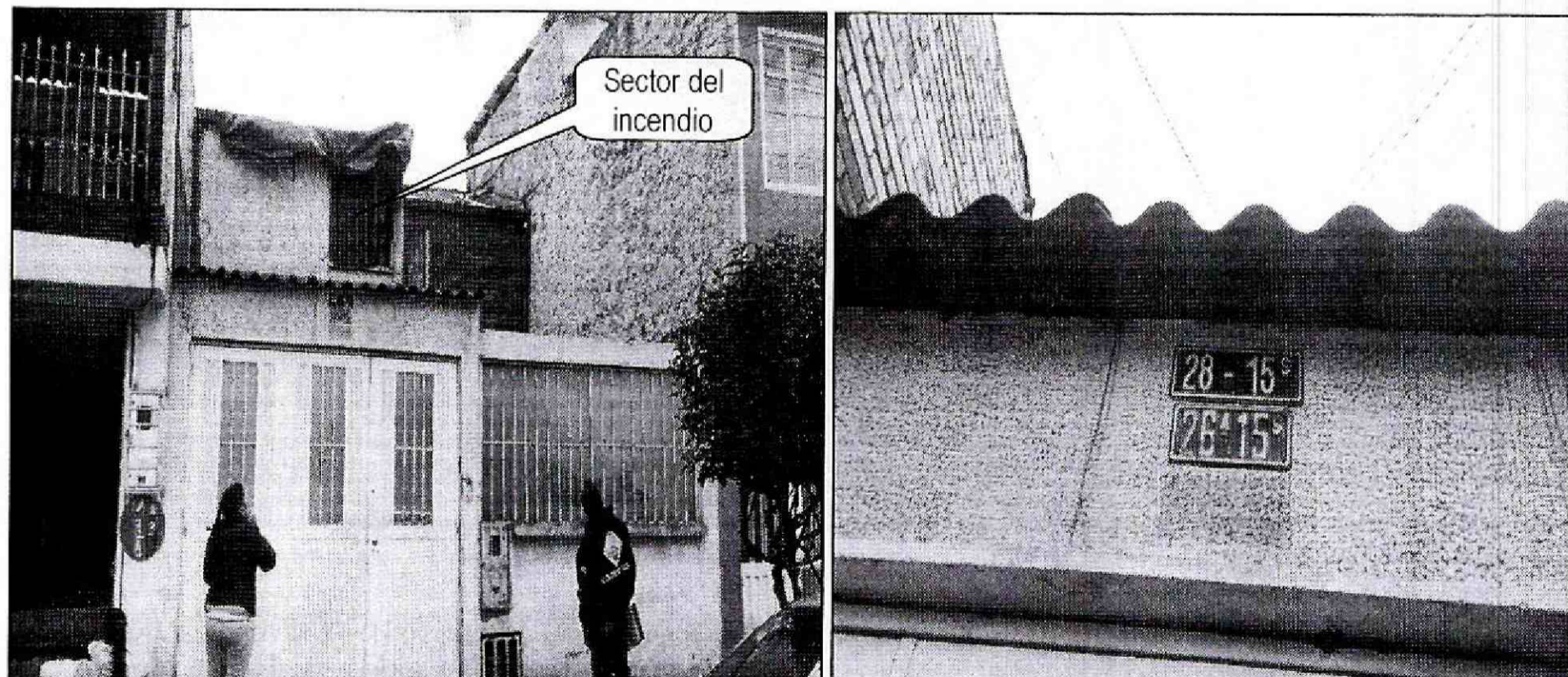
Fotografía 1 y 2. Localización general del Predio ubicado en la Carrera 39B No. 28-15 Sur del Sector Catastral Autopista Muzú, Localidad de Puente Aranda
