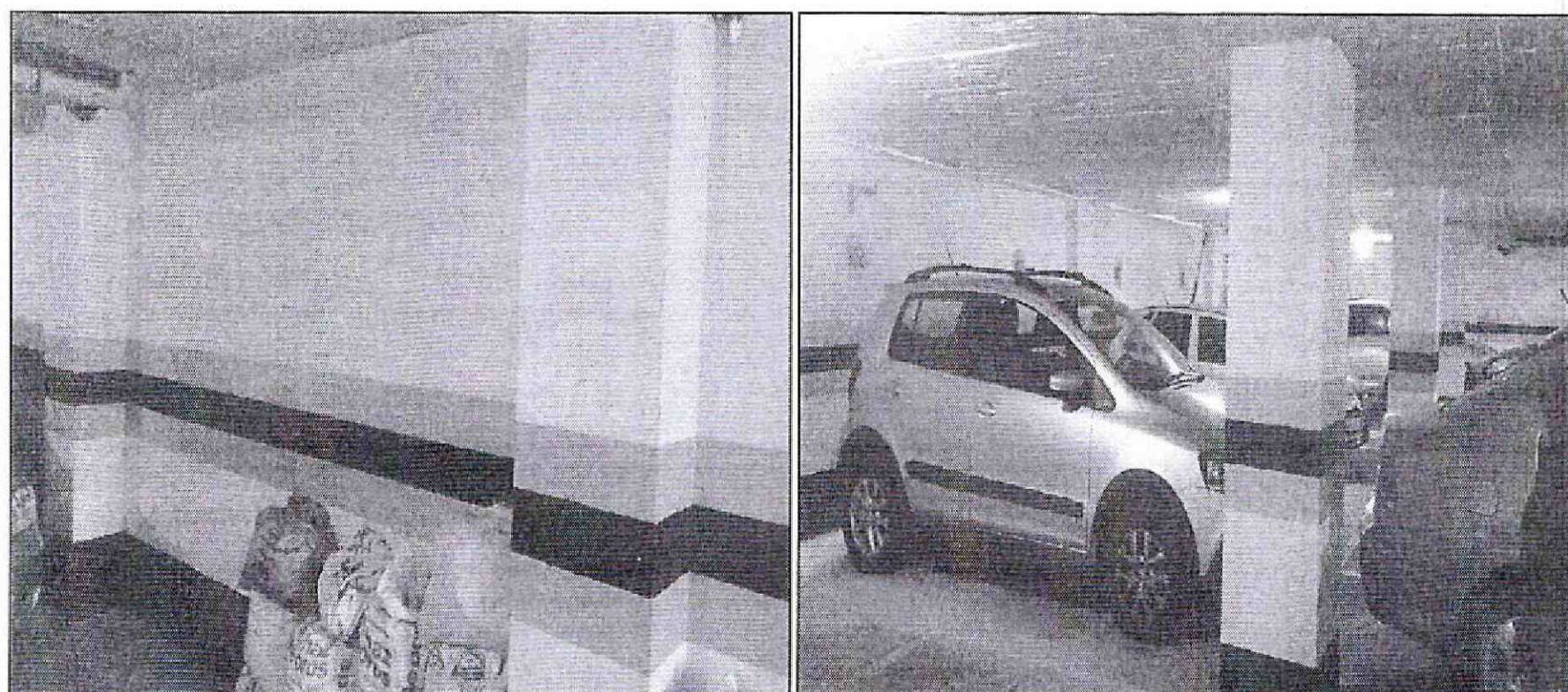
Fotografía 8 y 9. Vista de las columnas y muros pantalla del semisótano del Edificio Sierra Morena ubicado en la Calle 114 No. 56-62 del Sector Catastral Puente Largo de la Localidad de Suba, elementos que no presentan afectación.
