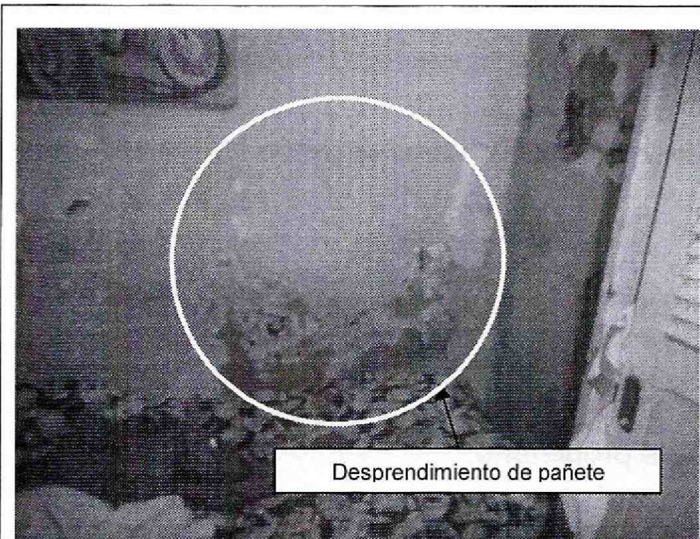
Foto 9. Desprendimiento de pañete evidenciado en uno de los muros de una habitación ubicada al costado nororiental del predio de la Calle 6A # 8A-20, el Sector Catastral Santa Bárbara de la Localidad de La Candelaria
