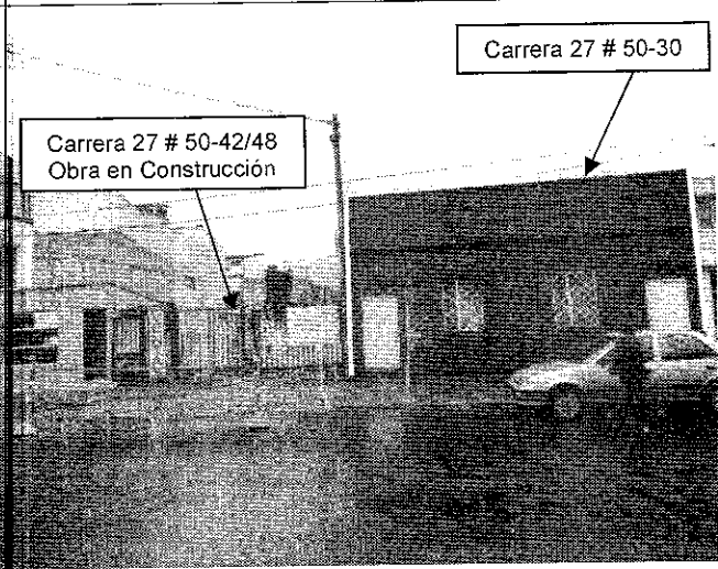
Foto 1. Vista general del predio de la Carrera 27 # 50-30 del Sector Catastral Alfonso López en la Localidad de Teusaquillo
