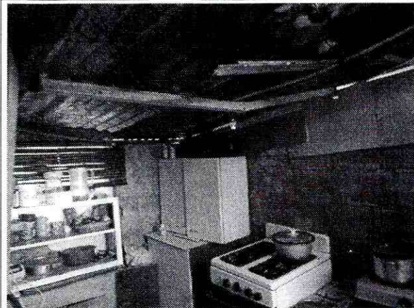
Fotos 4 y 5. Se aprecia el sistema constructivo combinado de la vivienda emplazada hacia el costado Sur-Occidental del predio con nomenclatura Carrera 18P Bis A No. 65A-02 Sur del Barrio Las Delicias del Sur de la Localidad de Ciudad Bolívar, compuesto por material de recuperación (láminas de zinc y madera) y en muros de carga en mampostería simple.
