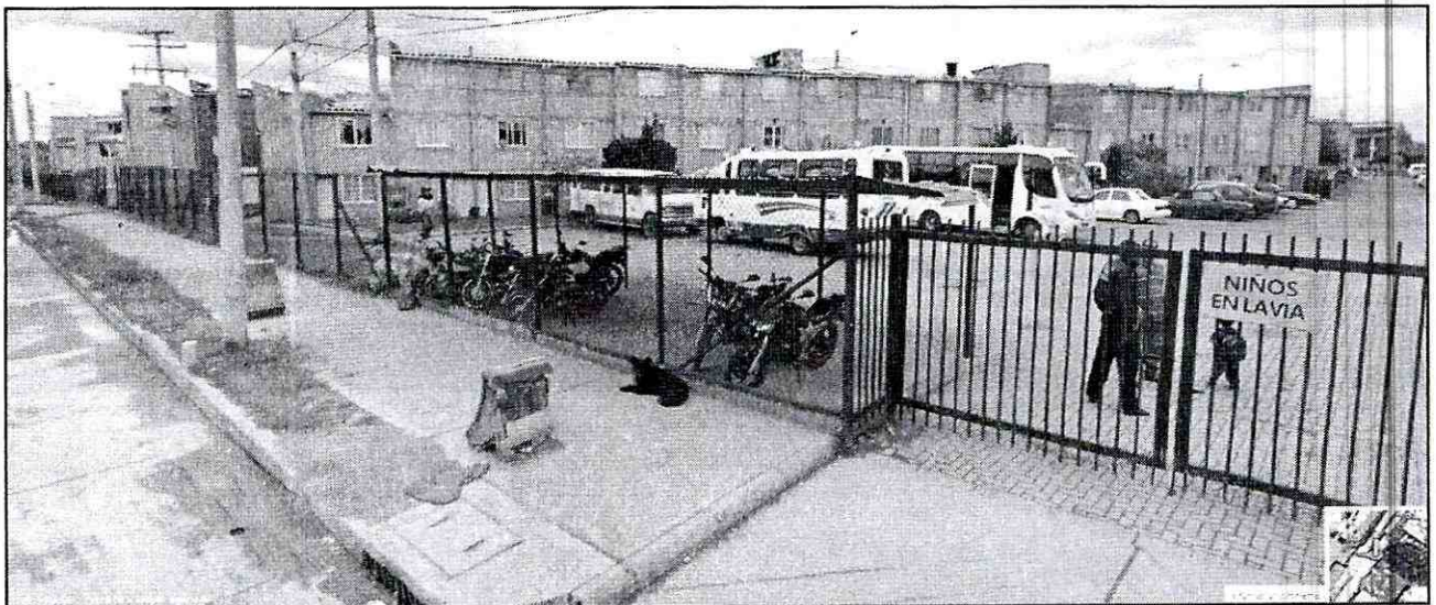
Fotografía 1. Localización general del Conjunto Villa Confenalco ubicado en la Carrera 140B No. 131-10 del barrio Tibabuyes, Localidad de Suba donde se encuentra el predio afectado por incendio el cual corresponde a la Manzana G Casa 47
