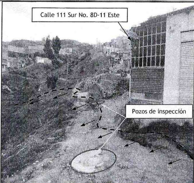
Fotografía 5. Pozos de inspección del sistema de aguas residuales del sector evaluado, los cuales se encuentran dentro de la zona de influencia del proceso de remoción en masa evaluado
