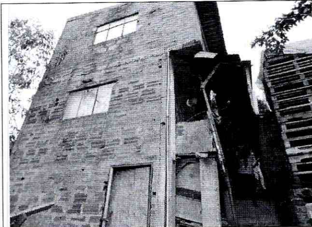
Foto 5. Vista general de la construcción de tres (3) niveles, que se emplaza en la zona frontal del predio (costado oriental).
