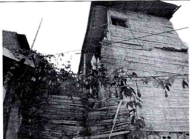
Foto 6. Vista general de la construcción de tres (3) niveles, que se emplaza en la zona frontal del predio (costado occidental).
