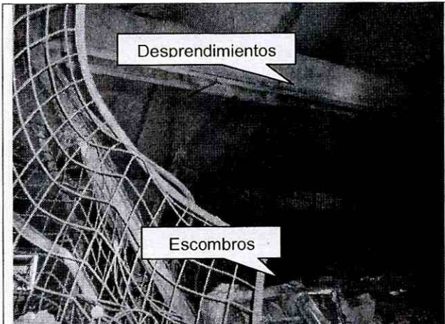
Foto 7. Vista de una fracción del interior del edificio en concreto, donde se observan los escombros de las sub-estructuras metálicas que conformaban los locales comerciales, se observa desprendimientos del material de recubrimiento de viga principal.
