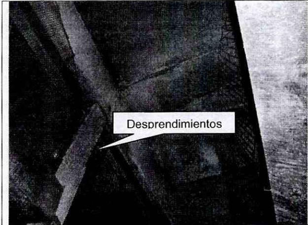
Foto 5. Vista de una fracción de la cubierta en placas de concreto de la zona donde se presentó la conflagración; se observa desprendimientos del concreto de placas, vigas y columnas que exponen el acero de refuerzo.
