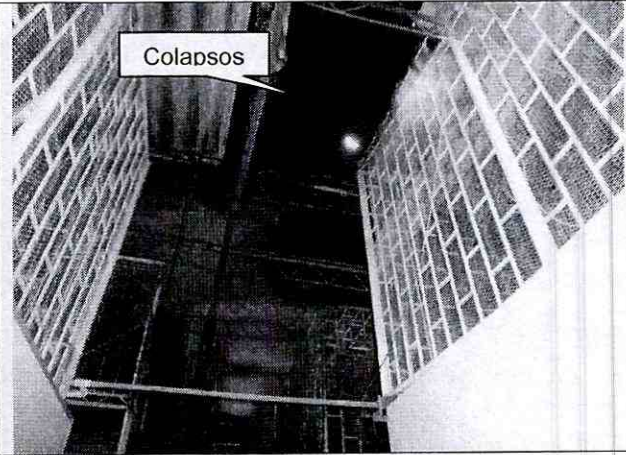
Foto 8. Vista de una fracción de la edificación que cuenta con cubierta liviana, donde se observan colapsos parciales de las tejas de "asbesto cemento" y del entramado metálico que las soporta (celosías metálicas).
