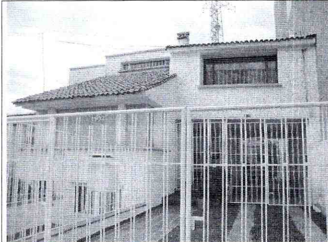
Foto 1. Vista de la fachada de la vivienda emplazada en el predio de la Calle 140 No. 19 - 30/32/34
