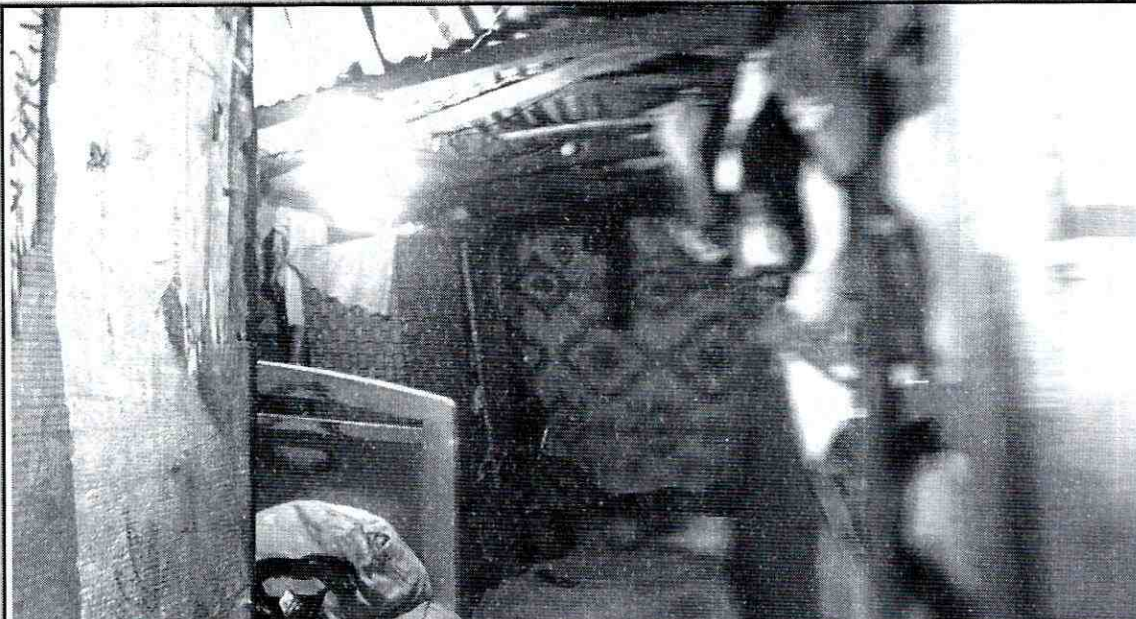
Foto No. 2. Vista al interior de la vivienda emplazada en el predio de la Carrera 18 Q No. 62 A 17 Sur, Manzana 40 - Lotes 44 (UAECD), del Barrio La Esperanza de la Localidad de Ciudad Bolívar.
