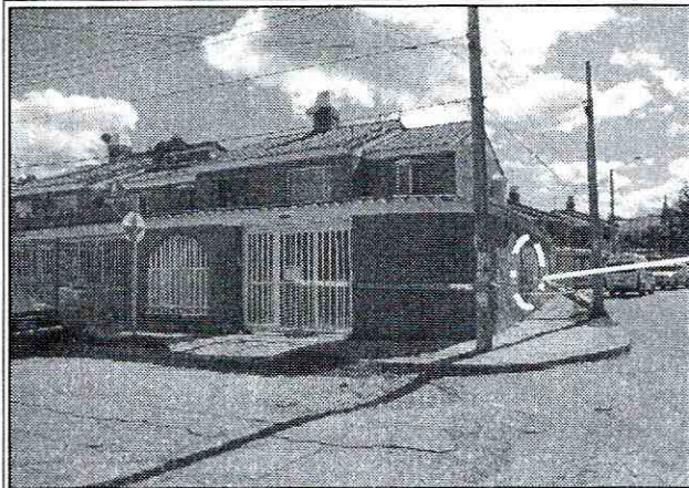
Fotografía 1. Vista de la fachada de la vivienda emplazada en el predio de la Carrera 95A No. 147B-35, Barrio Las Flores de la Localidad de Suba.
