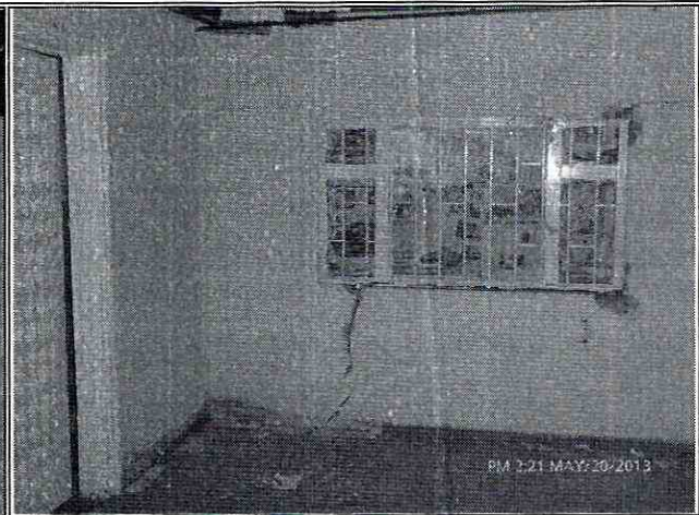
Fotografía 3 y 4. Se identifica al costado norte de la vivienda emplazada en el predio de la Carrera 7G No. 163A-77, en los muros de cerramiento y divisorios, grietas de tendencia horizontal y verticalidad con aberturas de 5 centímetros y 3 centímetros, alcanzando longitudes entre los 0.50 metros y los 2.50 metros.
