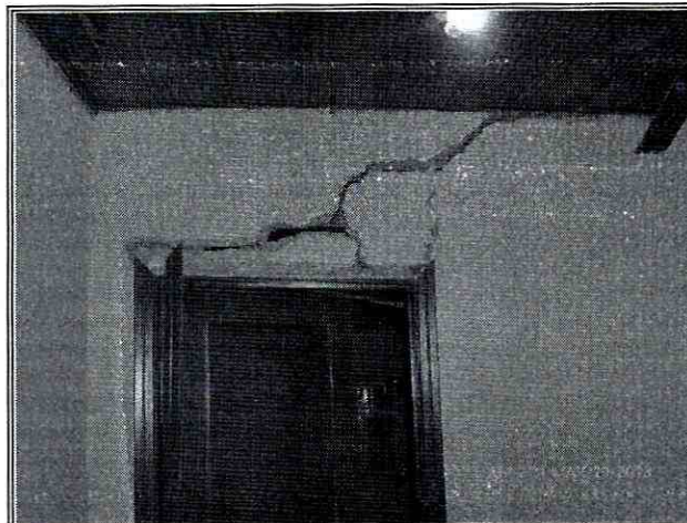
Fotografía 3 y 4. Se identifica al costado norte de la vivienda emplazada en el predio de la Carrera 7G No. 163A-77, en los muros de cerramiento y divisorios, grietas de tendencia horizontal y verticalidad con aberturas de 5 centímetros y 3 centímetros, alcanzando longitudes entre los 0.50 metros y los 2.50 metros.
