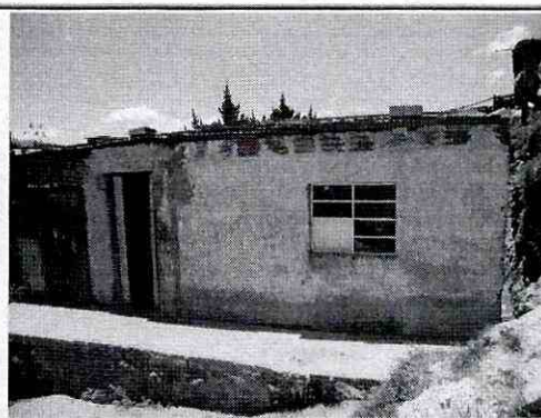
Fotografía 2. Vista de la vivienda emplazada en el predio de la Calle 82A Sur # 18N-52, ubicada hacia la parte baja del talud de corte evaluado.
