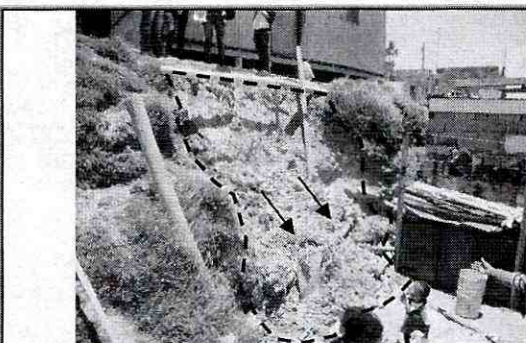
Fotografías 5 y 6. Se observa el desprendimiento local de material proveniente del talud de corte evaluado, el cual se depositó sobre el patio de la vivienda ubicada en la Calle 82A Sur # 18N-52.
