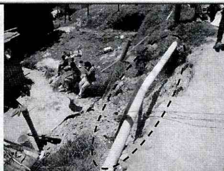
Fotografía 4. Se observa la tubería sanitaria ubicada en la parte alta del talud evaluado.
