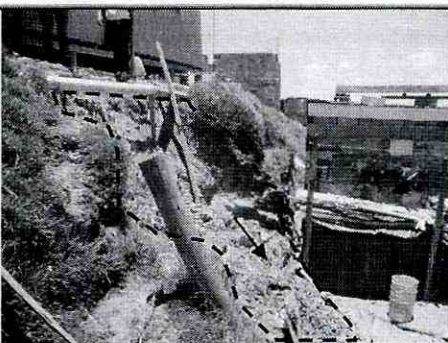
Fotografías 5 y 6. Se observa el desprendimiento local de material proveniente del talud de corte evaluado, el cual se depositó sobre el patio de la vivienda ubicada en la Calle 82A Sur # 18N-52.
