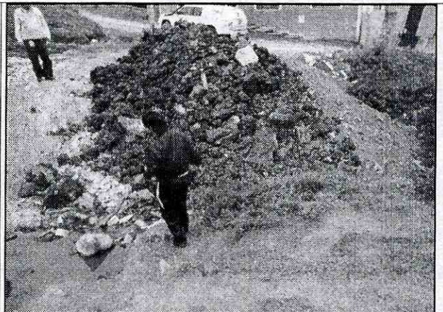
Fotografía 2. Al momento de la inspección visual se identificó al costado sur oriental del predio de la Transversal 17 Este No. 46D-75 Sur, un depósito de escombros, el cual según información del responsable del predio en mención, están siendo acumulados posiblemente por él, para desviar el Cauce de la Quebrada Chorro del Silverio y evitar la anegación del predio, situación que con base en la inspección visual no es posible corroborar.
