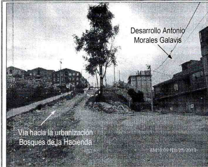
Fotografía 1. Vista del sector evaluado, ubicado en la Calle 48B Sur con Transversal 5G, en inmediaciones del desarrollo Antonio Morales Galavis y el sector catastral Puerto Rico, en la localidad de Rafael Uribe Uribe. Se observa en la parte alta de la ladera la Urbanización Bosques de la hacienda.
