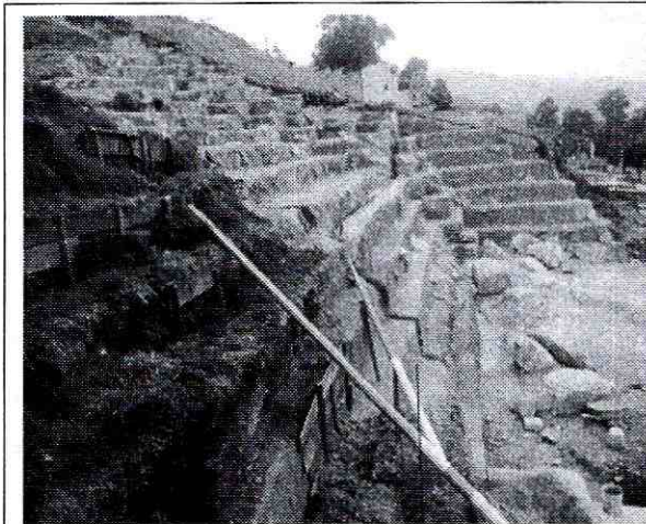
Foto 10 - Terrazas implementadas parte media de la ladera con sistema de drenaje superficial
