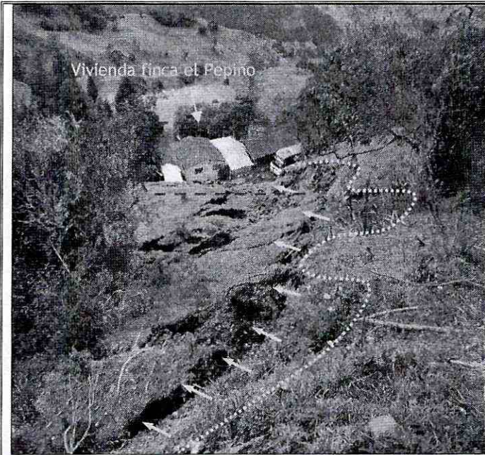
Fotografía 5. Vista de la vivienda de la finca el Pepino, se observa que la vivienda se encuentra dentro de la zona de influencia del proceso de remoción en masa evaluado.
