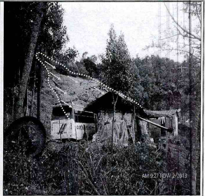
Fotografía 6. Vista de la vivienda de la finca el Pepino, se observa que la vivienda se encuentra dentro de la zona de influencia del proceso de remoción en masa evaluado.
