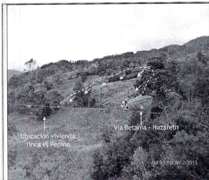
Fotografía 1. Vista del proceso de remoción en masa en la vía Betania - Nazareth, en visita realizada el 02 de Noviembre de 2013, se observa la localización de la vía y de la vivienda de la finca el Pepino.
