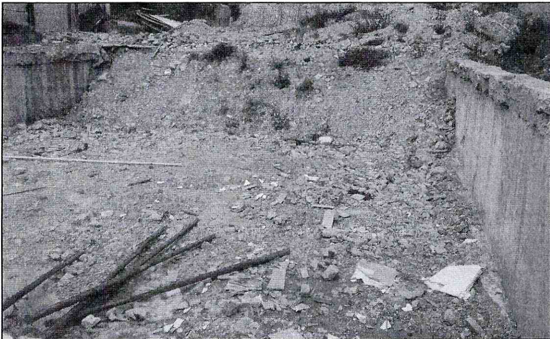
Fotografía 2. Se observan los lotes correspondientes a la Calle 26A No. 3 – 04/10 donde se evidencian los trabajos de nivelación para el proyecto inmobiliario "Think – Apartamentos"
