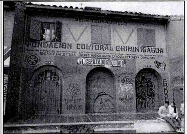
Fotografía 2. Vista general de la fachada de la edificación emplazada en el predio de la Avenida Caracas No. 40A-29, Sector Catastral La Magdalena de la Localidad de Teusaquillo.
