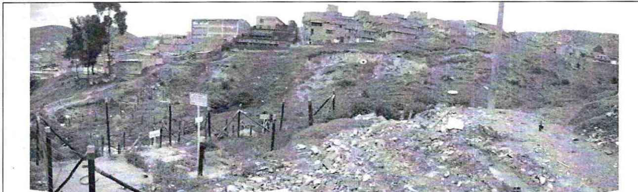
Fotografía 7. Vista de la margen izquierda de la Quebrada del Infierno donde se identifican varios procesos de remoción en masa que posiblemente se encuentren relacionados con la dinámica propia de la quebrada. (Toma desde el Costado Sur de los predios de la Carrera 18 A Bis No. 78 C-38 Sur (Un. Hab. 1 y Un. Hab. 2). y Carrera 18 A Bis No. 78 C-44 Sur).
