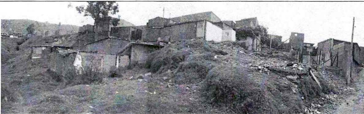
Fotografía 2. Vista de la parte posterior de las viviendas ubicadas en la Carrera 18 A Bis No. 78 C-38 Sur (Un. Hab. 1 y Un. Hab. 2) y Carrera 18 A Bis No. 78 C-44 Sur y del sector el Barrio Buenos Aires II donde se realiza a la fecha el proceso de reasentamiento de predios recomendados en el Concepto Técnico CT-4472.
