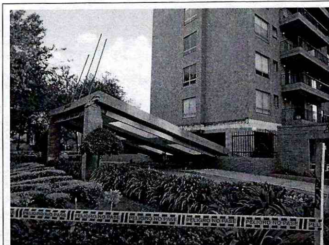
Fotografía 1. Fachada del predio donde se presentó el colapso de la cubierta.
