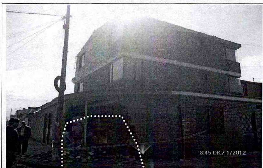
Fotografía No. 1. Se observa la vista general del lugar donde impacto el vehículo en el predio de la Carrera 71-6C-36.
