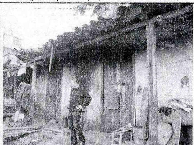
Foto 3 y 4. Estructura al interior del predio compuesta por dos edificaciones conformadas en muros en adobe y en ladrillo tolete, con cubierta en tejas de barro, entramado en madera y cielorrasos en esterilla de guadua y torta en mortero.
