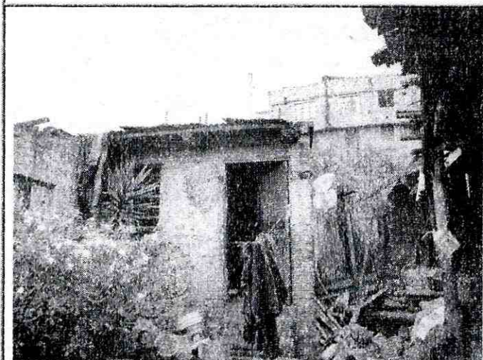
Foto 3 y 4. Estructura al interior del predio compuesta por dos edificaciones conformadas en muros en adobe y en ladrillo tolete, con cubierta en tejas de barro, entramado en madera y cielorrasos en esterilla de guadua y torta en mortero.
