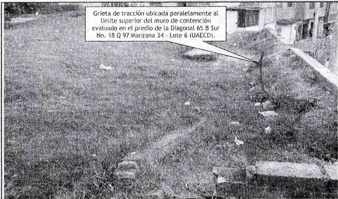
Foto No. 5. Vista general de la grieta de tracción ubicada paralelamente al límite superior del muro construido posiblemente como medida de contención de un talud de corte a la altura del predio de la Diagonal 65 B Sur No. 18 Q 97 Manzana 34 - Lote 6 (UAECD), del Barrio Las Delicias del Sur de la Localidad de Ciudad Bolívar.
