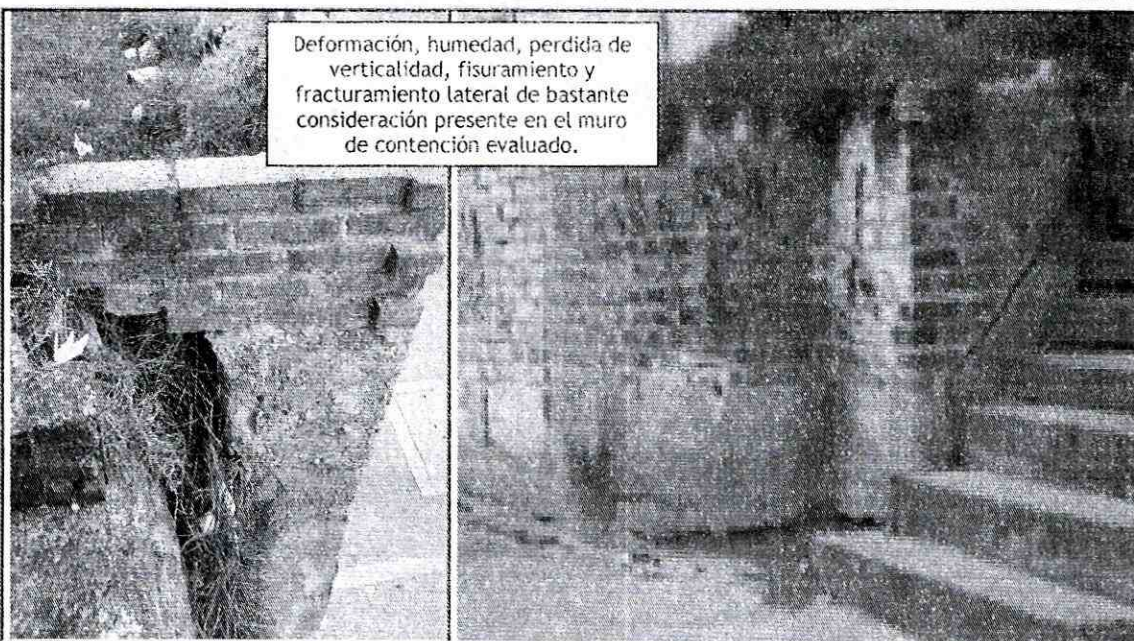
Fotos No. 2 y 3. Vista lateral del muro construido en mampostería simple, piedra pegada y concreto, implementado posiblemente como medida de contención de un talud de corte a la altura del predio de la Diagonal 65 B Sur No. 18 Q 97 Manzana 34 - Lote 6 (UAECD), del Barrio Las Delicias del Sur.
