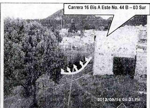
Fotografía 3. Desde el costado posterior de la vivienda se identifica el sector en donde se presentó el proceso de remoción en masa.
