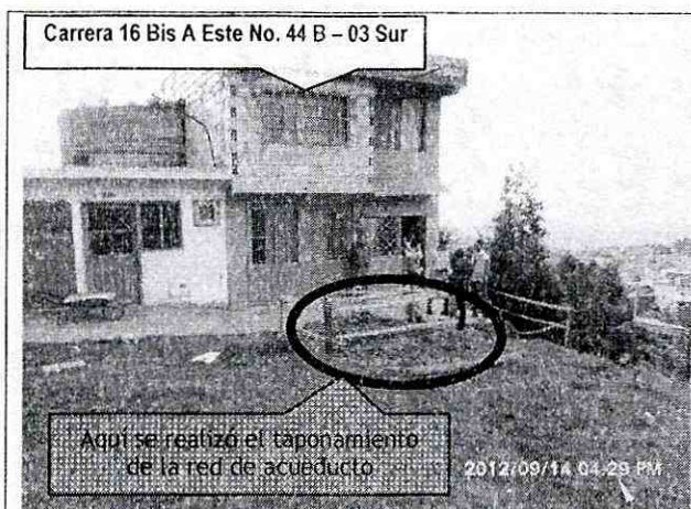
Fotografía 2. Identificación de la vivienda de la Carrera 16 Bis A Este No. 44 B - 03 Sur, del Sector Catastral Altos del Zuque de la Localidad de San Cristóbal.
