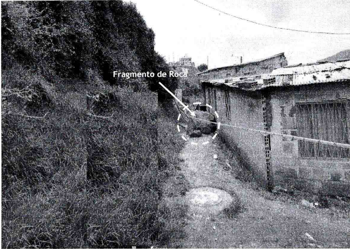
Fotografía 2. Se observa sobre la vía de acceso peatonal localizada en la Calle 48R Sur, uno de los fragmentos de roca que se desprendieron de la ladera evaluada.
