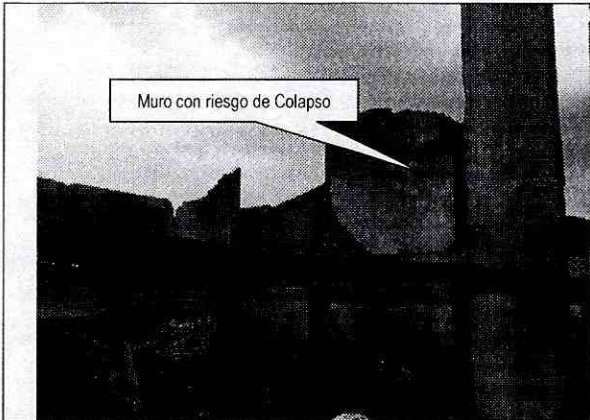
Foto 5. Vista general de la zona posterior del predio de la Calle 66A # 95-35 y Calle 66A # 95-11 (donde se presentó el incendio), en el costado donde colindan con los muros del predio de la Calle 65A # 93-28, se observa un muro que presenta riesgo de colapso.
