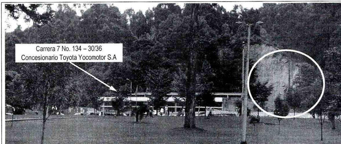
Fotografía 1. Vista general del concesionario Toyota Yocomotor S.A. y del talud de corte en roca localizado hacia la parte posterior de la edificación del concesionario. Nótese la altura del corte y el sector desde el cual se presenta el desprendimiento de bloques.
