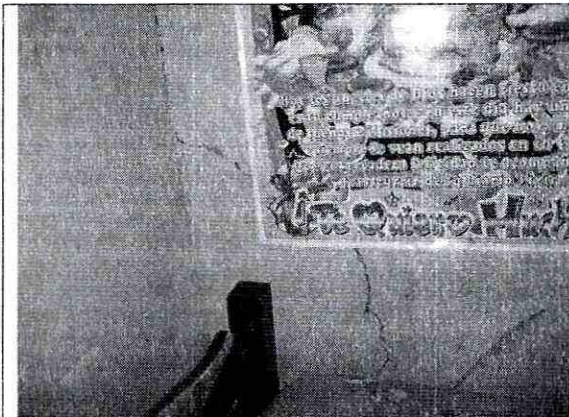
Foto 3 y 4. Se aprecia el agrietamiento con aberturas mayores a 2cm y tendencia diagonal en los muros de cerramiento de la vivienda con nomenclatura Carrera 18D Bis # 81A-35 Sur.
