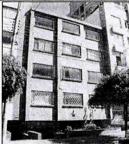
Foto 4. Edificio de la Calle 145A No 21-52, tomada del DI-4421, en donde aun no se observa la severidad de los daños observados en la fachada del segundo y tercer nivel.
