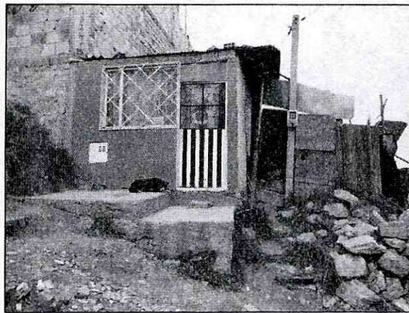
Fotografía No. 1. Se observa la fachada del predio de la Carrera 6A Este No. 80A - 23 Sur, Barrio Compostela I de la Localidad de Usme.
